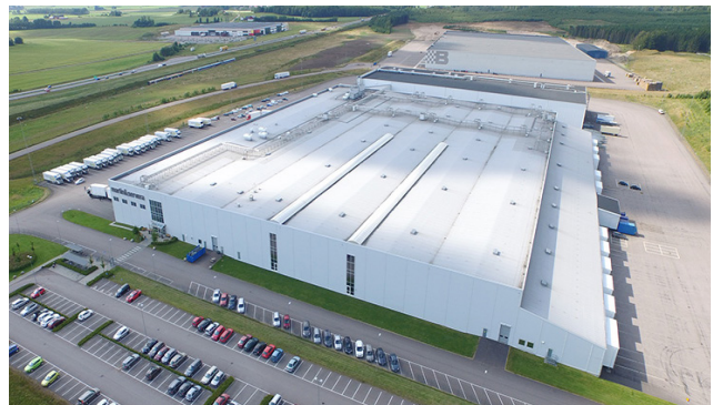
Fastighet: Vrangelstro 5:4, Halmstad Bild hämtad från: https://www.halmslatten.se/
